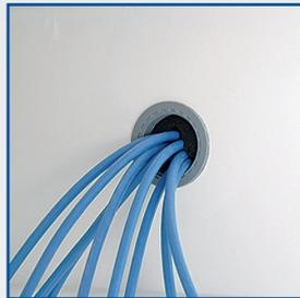
Passage de cuve Ø 30mm pour caractérisation/qualification sur site, positionné sur le côté droit à 1/3 du haut.
